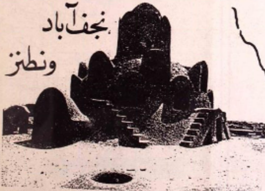
Ventilation Shaft (Kashan)
